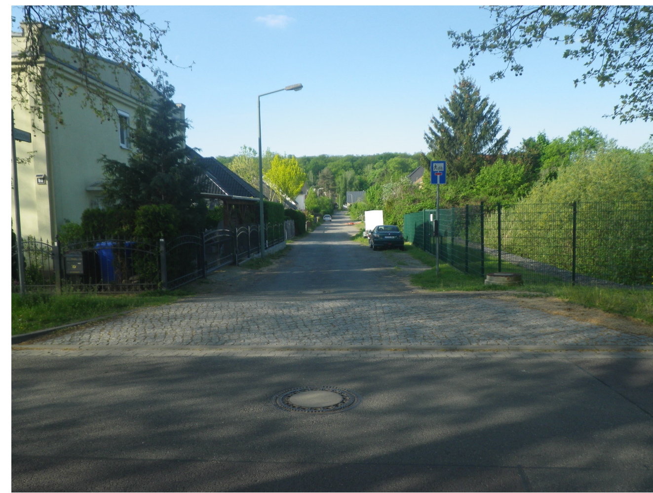
Foto 1: Gersthofweg, Beginn der Baustrecke = Ende der Pflasterbefestigung = Station 0+000
